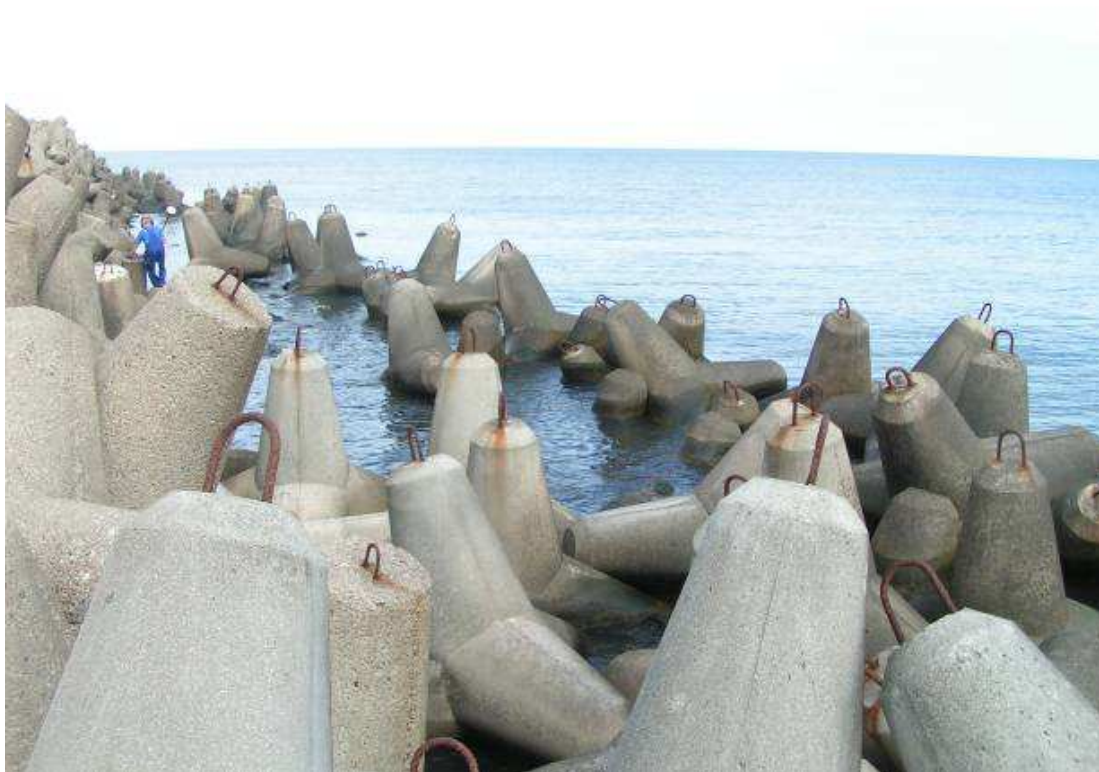
Fot. 7 Ubytki (osiadanie) narzutu z gwiazdobloków w części przygłowicowej..
