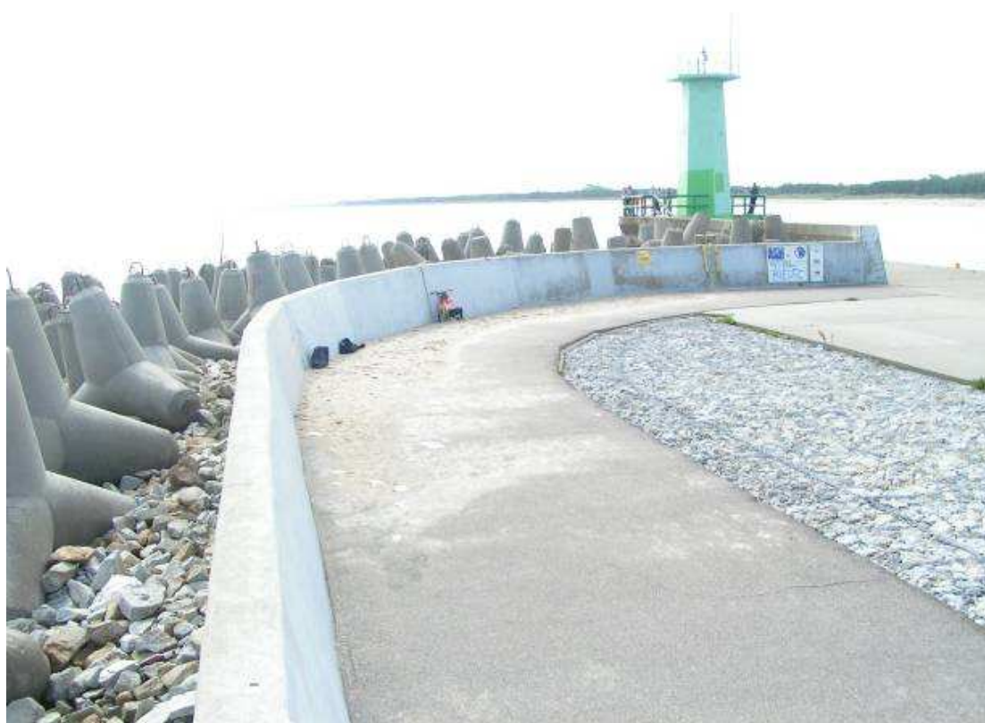
Fot. 5 Część połączeniowa falochronu z głowicą
