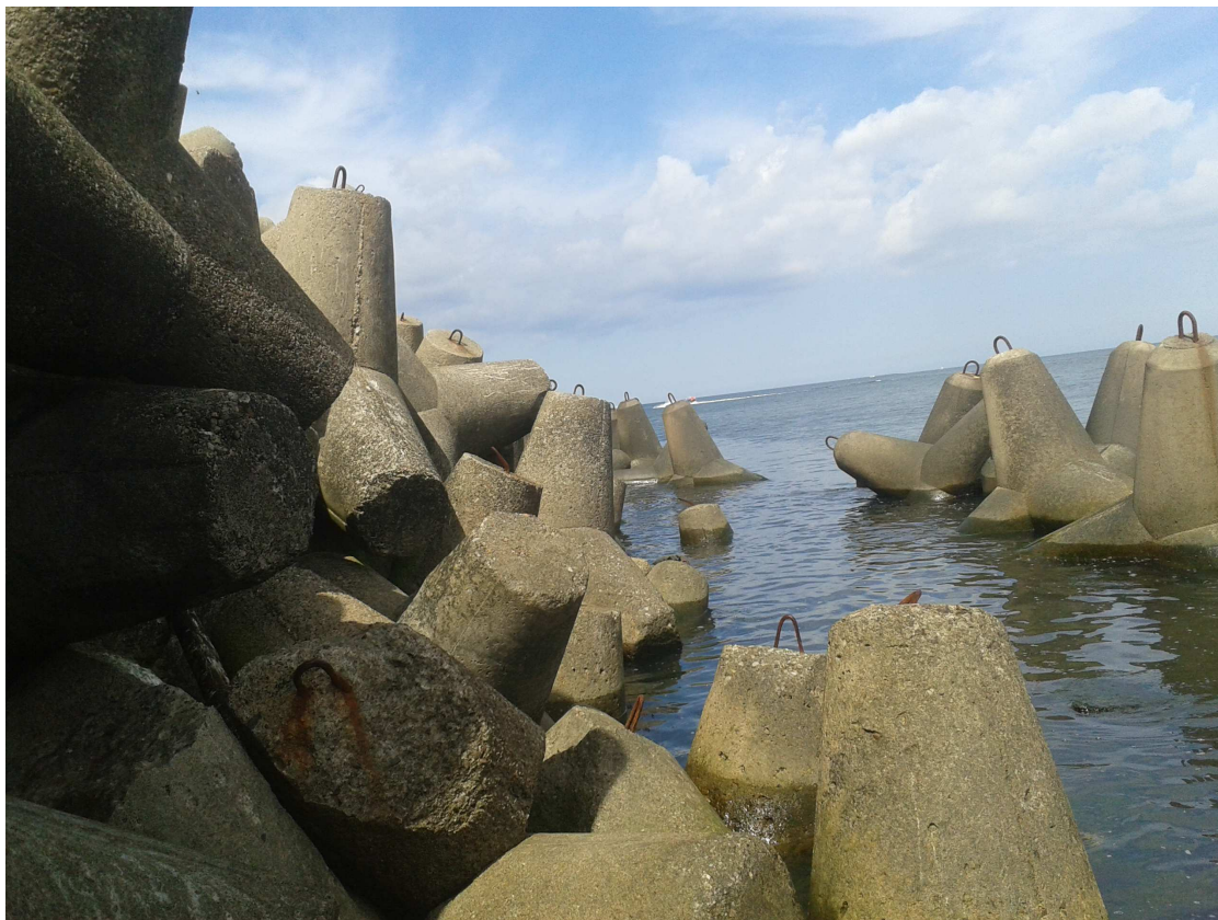
Fot. 6 Ubytki (osiadanie) narzutu z gwiazdobloków - szczegół.
