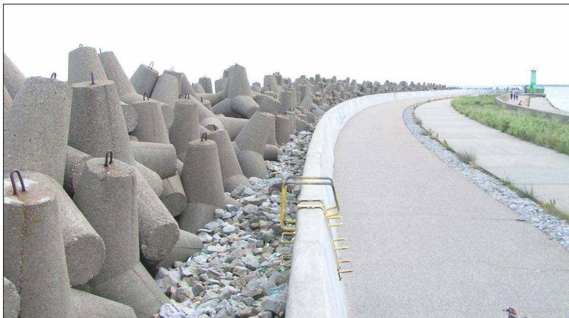
Fot. 4 Część zasadnicza falochronu
