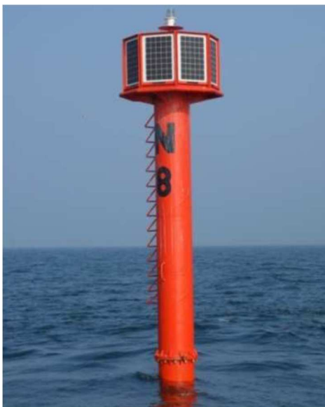
Fot. 13 Znak nawigacyjny - pława typu "Spar Buoy" proponowana do oznakowania toru podejściowego
