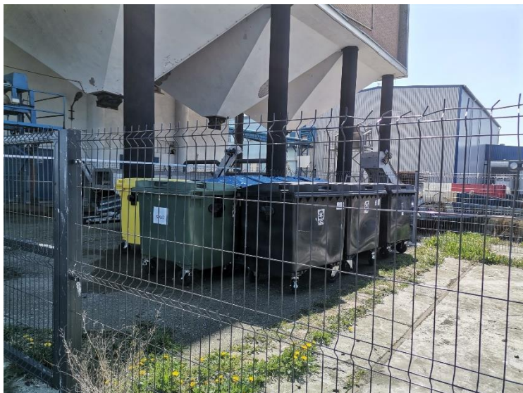
Fot.: urządzenia do odbioru odpadów na Nabrzeżu Wyładunkowym
